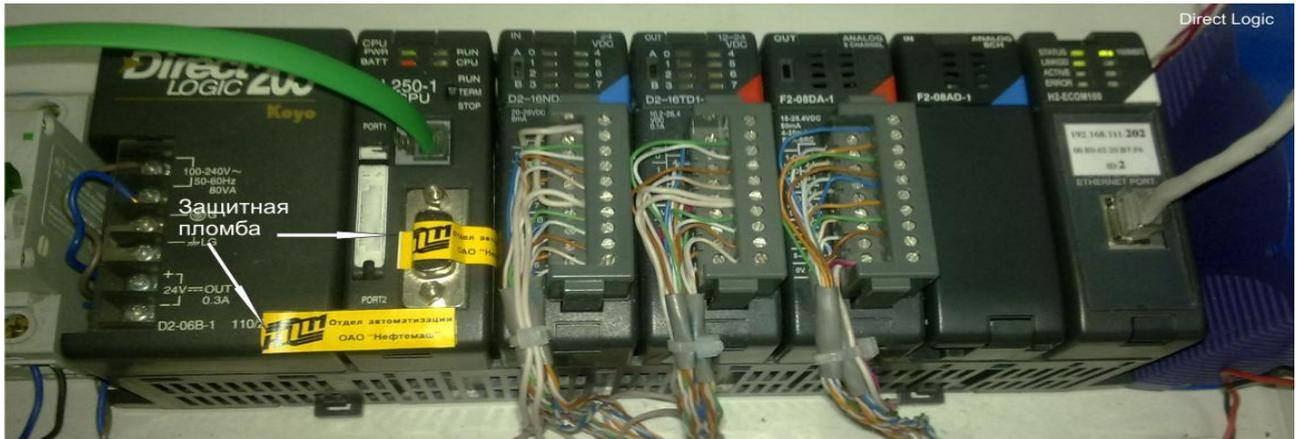
Рисунок 2 - Схема пломбирования контроллера «Direct Logic»
