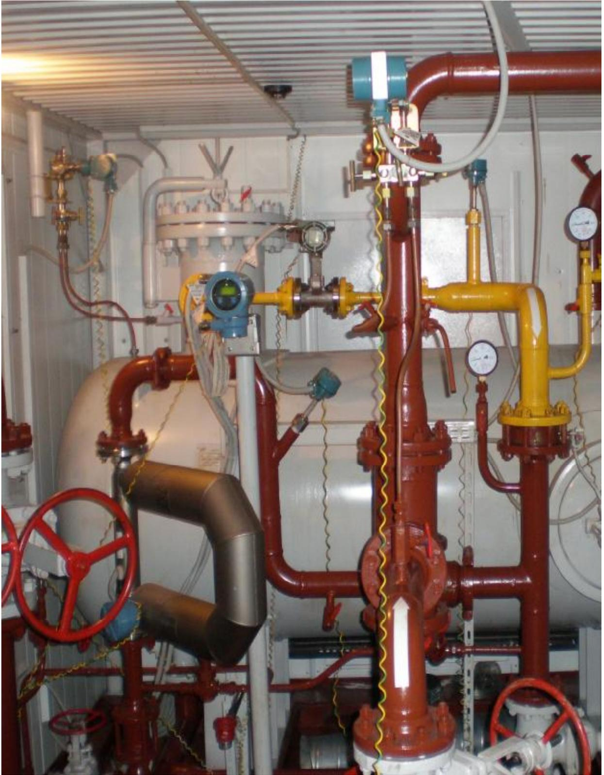
Рисунок 1а - Установка измерительная «Мера-ММ». Общий вид.
