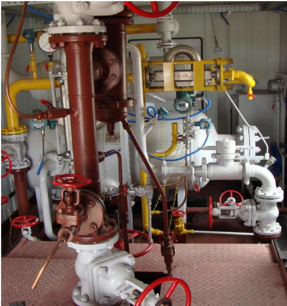
Рисунок 1 - Установка измерительная «Мера-ММ». Общий вид.
